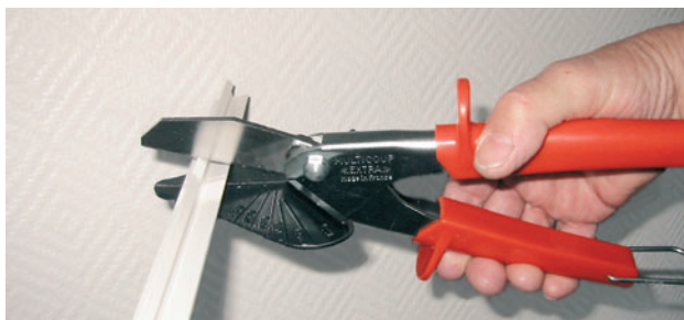
6. Foglist T klipps med profilsax till rätt längd som tvärgående list.
