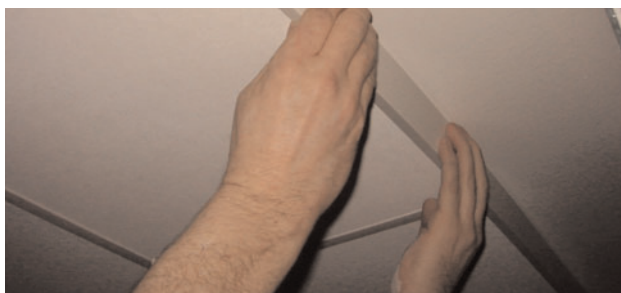
9. Kantprofil U trycks fast på fältets ytterkanter.
