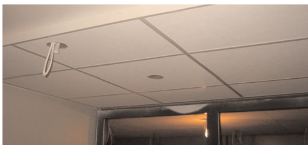
10. Färdigt montage med lister.
