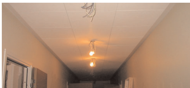
5. Färdigt montage utan lister.
